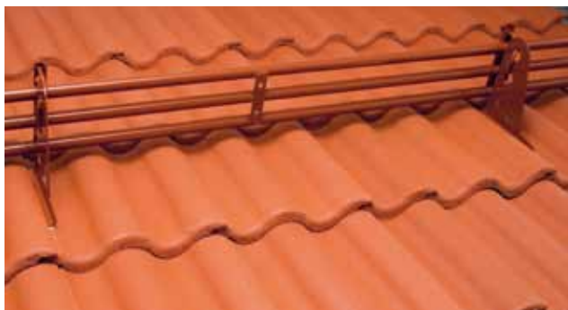
Bild 19. Snörasskydd grind komplett monterad på tak.
