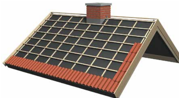
Bild 7. Lägg först en nedre rad från höger till vänster. Sedan en rad ända upp till nocken. Se till att den ligger i vinkel mot nedersta pannraden.
