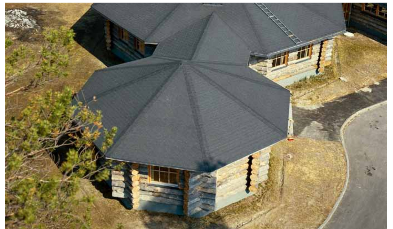
En spännande takutformning med många vinklar. Inga problem att lägga Shingel här heller.
